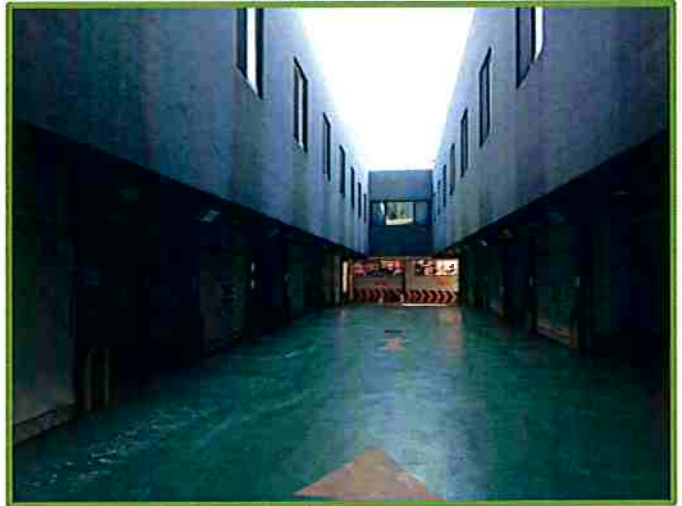
기호(가) 건물의 1층 주차장 전경
