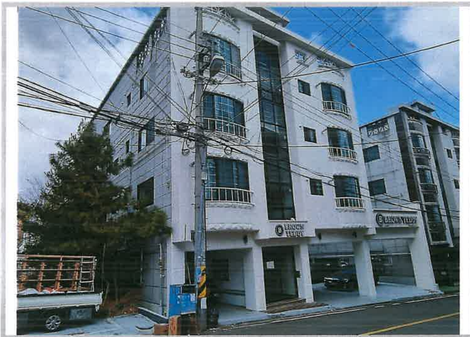
본건 전경(남동측에서 촬영)
