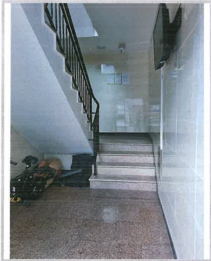
본건 1층 계단실 전경
