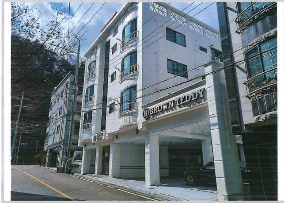
본건 전경(북동측에서 촬영)
