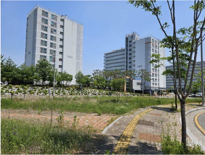
본건 전경(본건 북서측에서 촬영)
