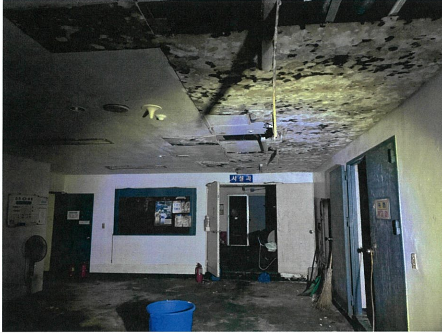
본건 기호 가) 지하2층 내부
