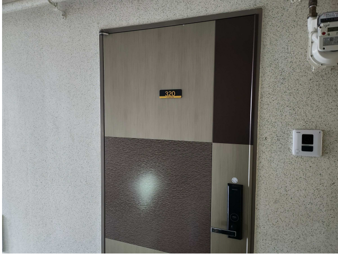
11-자) 3층 320호 압구 전경
