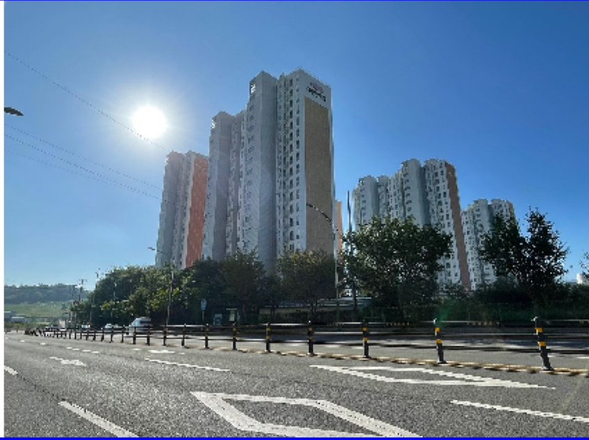
【 본건 북서측 전경 】
