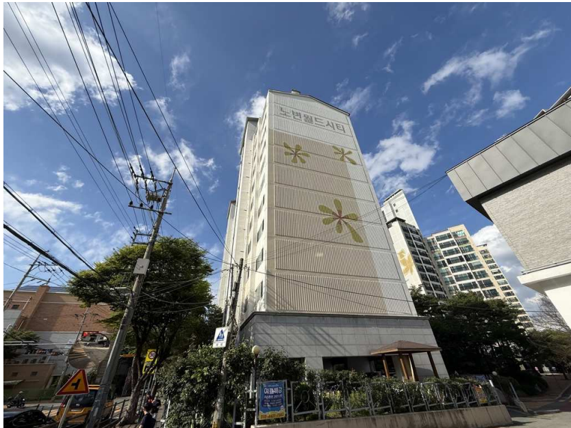
[ 대상물건 남서측 전경 ]
