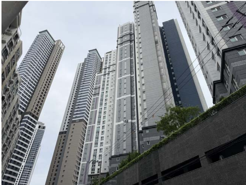
[ 대상물건 전경 (102동) ]
