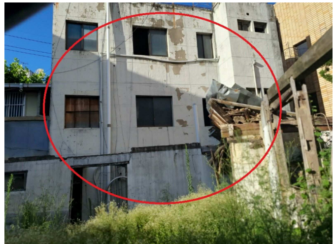
기호3(가)건물 후면부 전경
