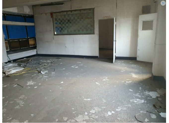
기호3(가)건물 내부 전경 예시2
