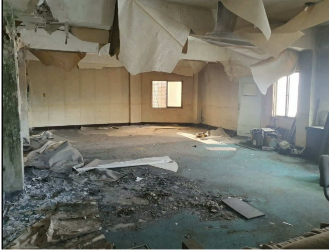
기호3(가)건물 내부 전경 예시1
