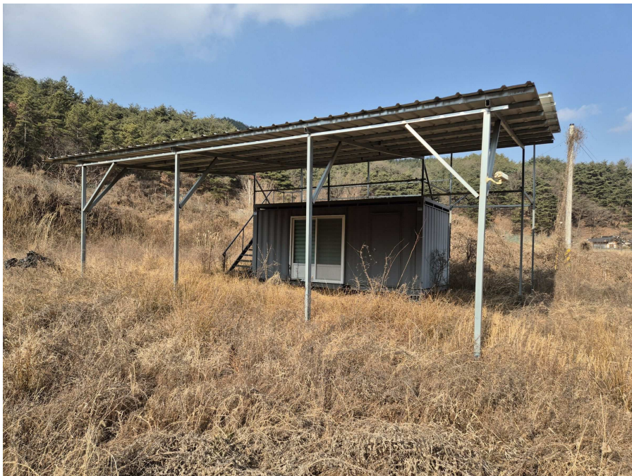
대상 토지(4) 지상 제시외건물(ㄱ) 전경
