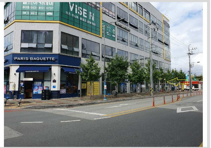
본건 상가동 남동측 전경
