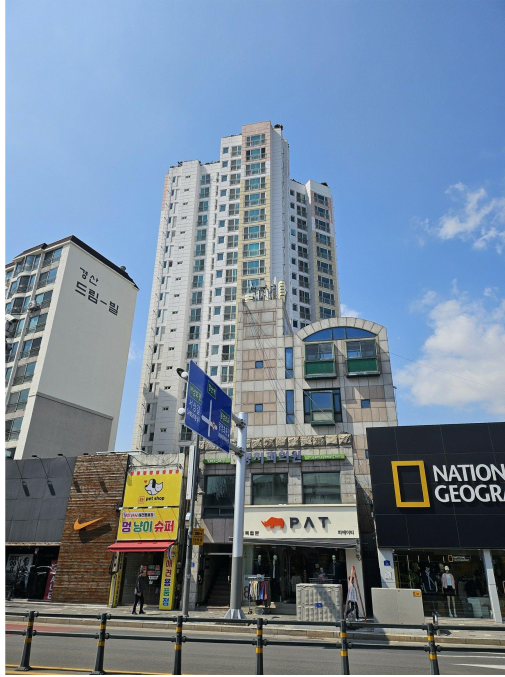
본건 전경 - 남동측에서 촬영
