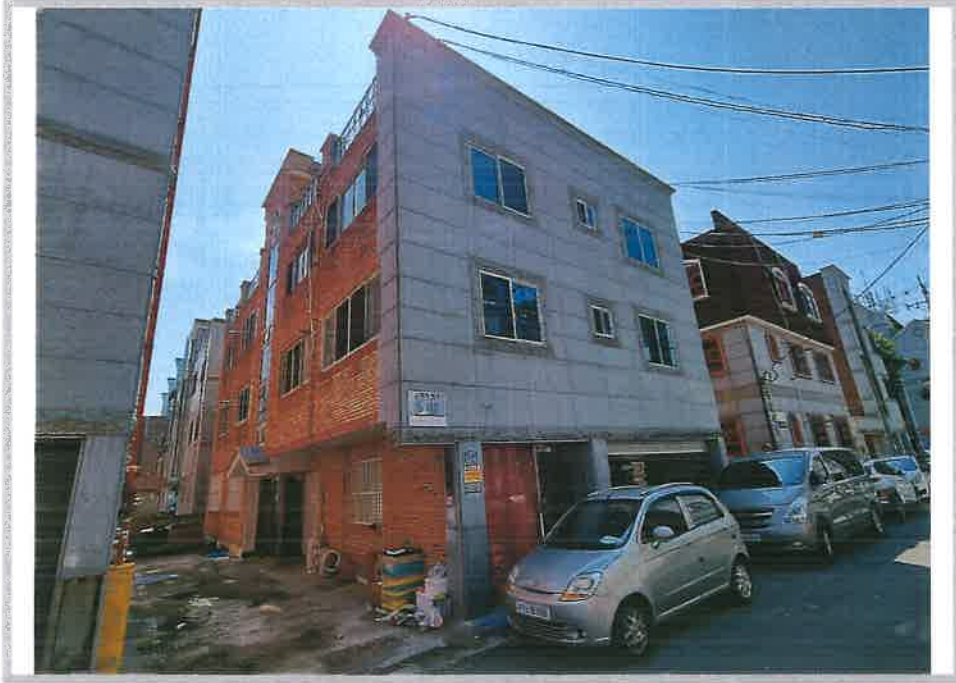
본건 전경(북서측에서 촬영)
