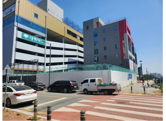
본건 전경(남서측에서 촬영)
