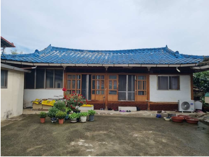
본건 전경(본채-목조 기와지붕)
