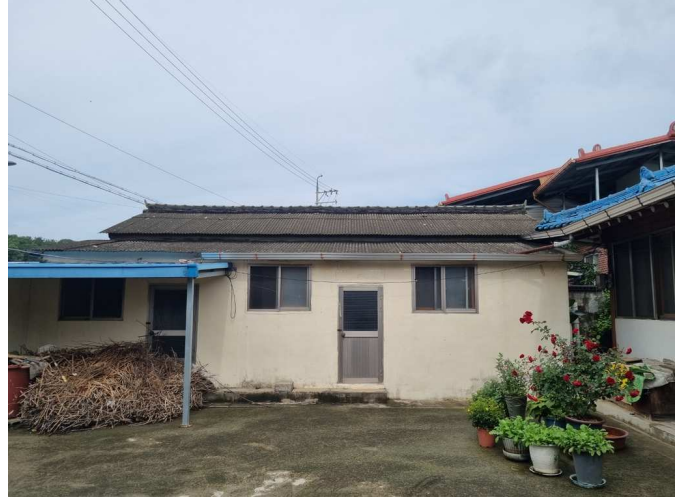
본건 전경(블럭조 스투트지붕)
