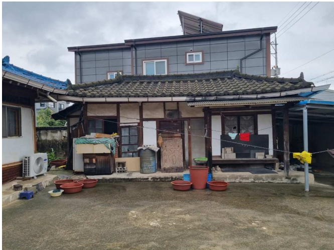
본건 전경(목조 기와지붕)
