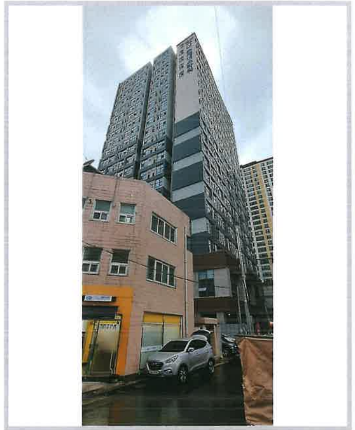
본건 전경(남동측에서 촬영)
