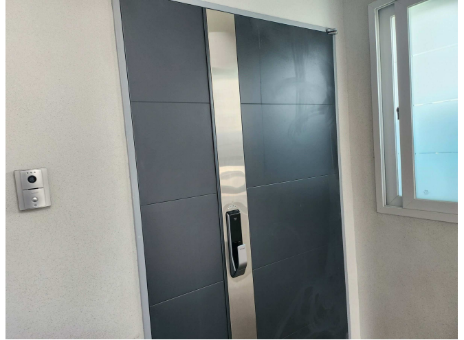
건물 2층 입구 전경
