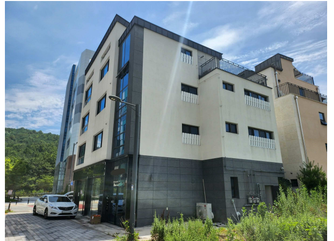
본건 전경 (북서측에서 촬영)
