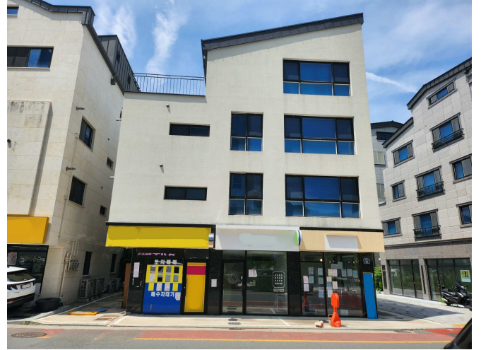
본건 전경 (북동측에서 촬영)
