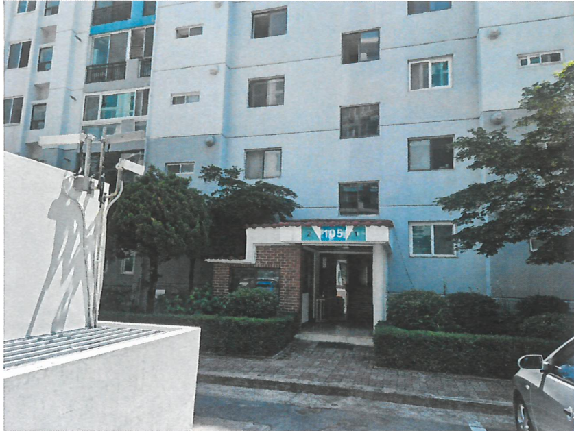
본건 1층 출입구
