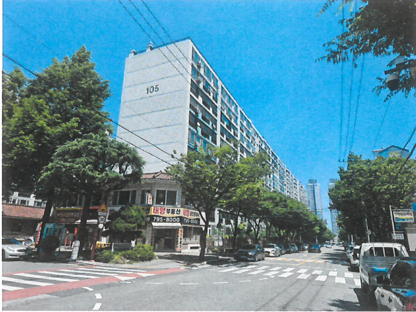
본건 전경 (남서측에서 촬영)
