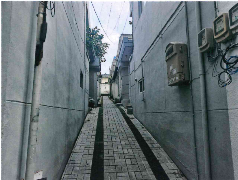
본건 진입도로 전경
