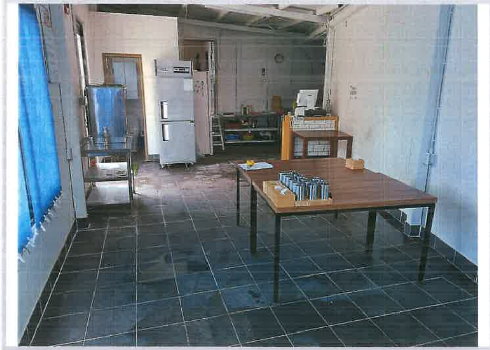
본건 기호 2) 건물 내부 및 제시외 건물 ㄱ) 전경
