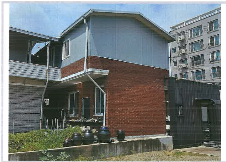
본건 기호 4-1)건물(1층) 및 제시외건물(ㄷ)(2층)
