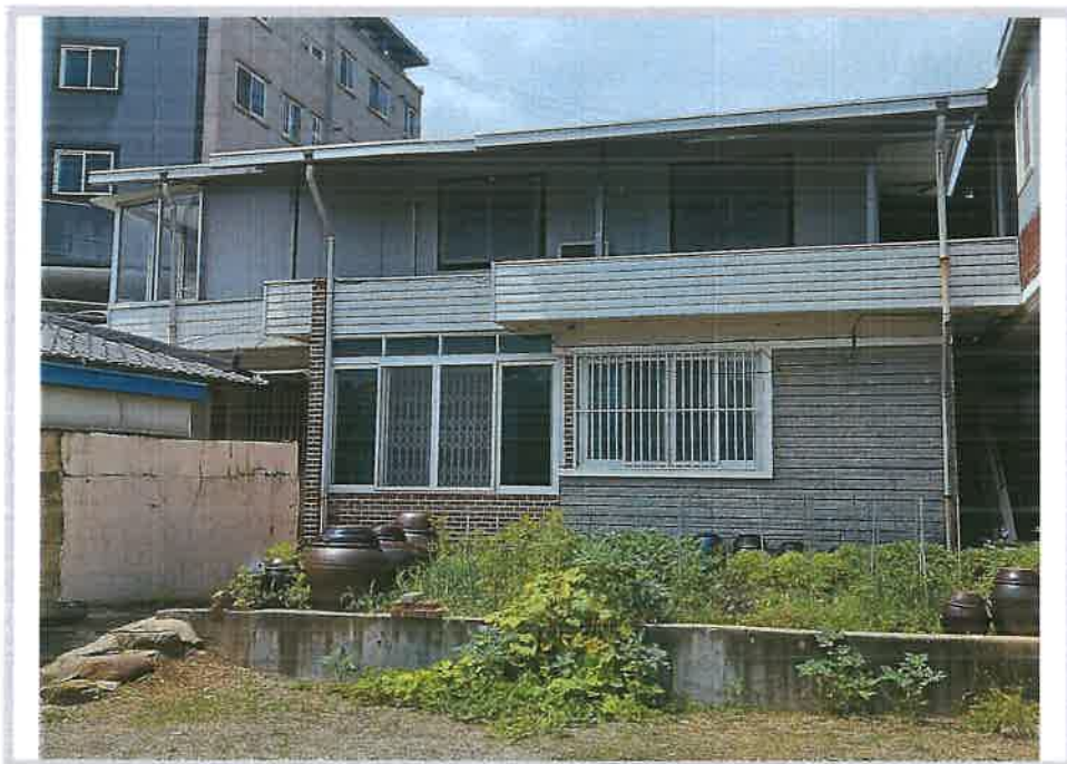
본건 기호 4) 건물(1층) 및 제시외 건물 ㄷ)(2층)
