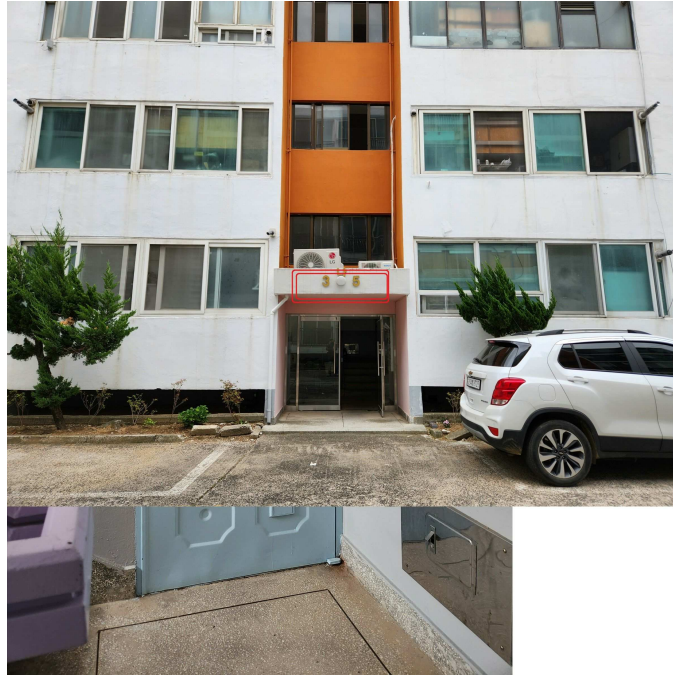
3, 4호 라인 지상 출입구 전경
