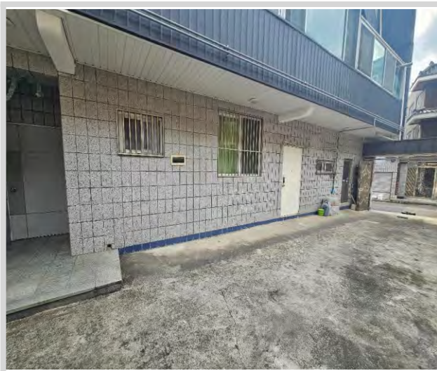
본건 기호 가) 1층 촬영
