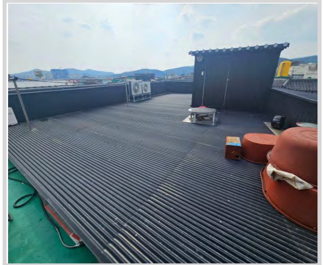
본건 강판지붕 보수부분 촬영
