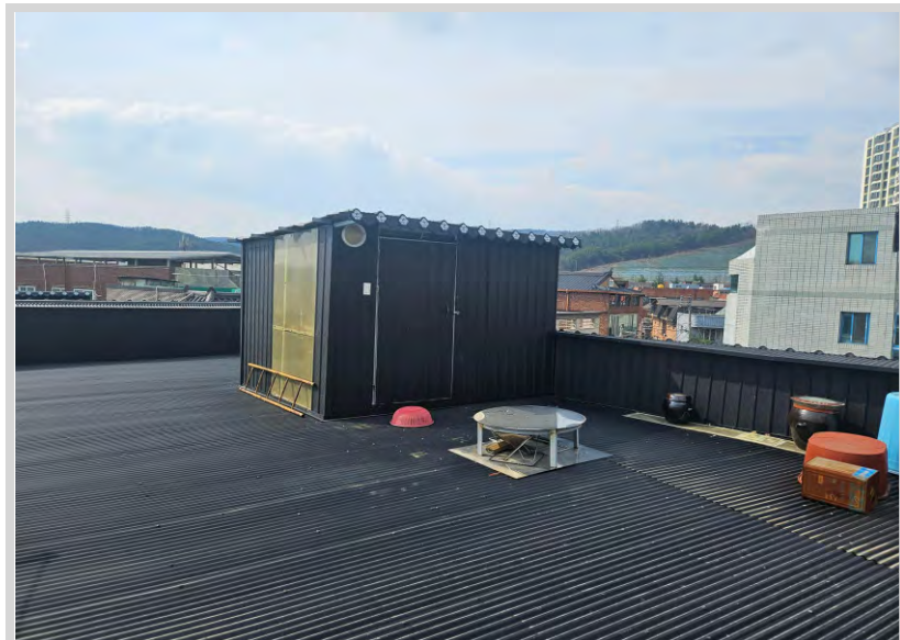
본건 제시외 건물 ㉖) 촬영
