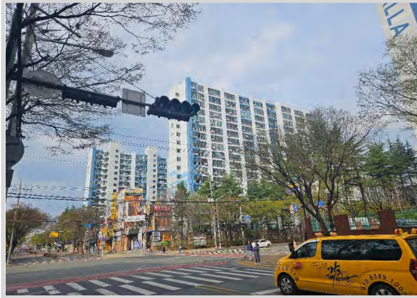
본건 아파트전경 촬영
