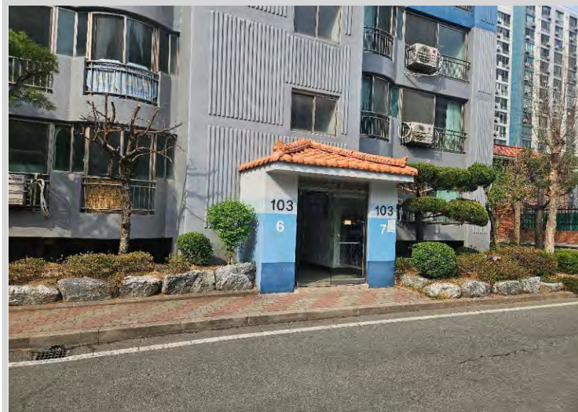
본건 아파트 동 출입구 촬영
