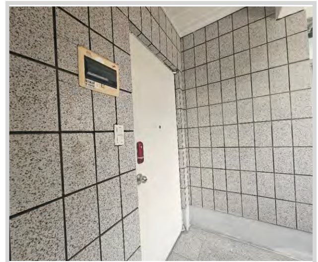
본건 기호 가) 2층 촬영
