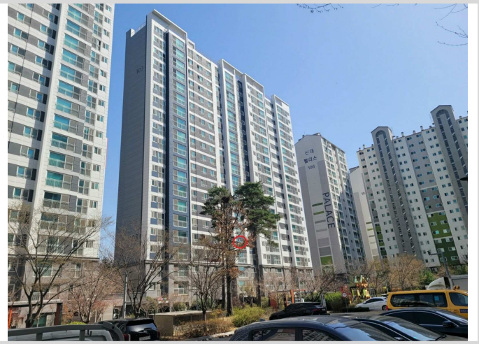
본건 및 건물동 전경 (서측 주변에서 촬영)
