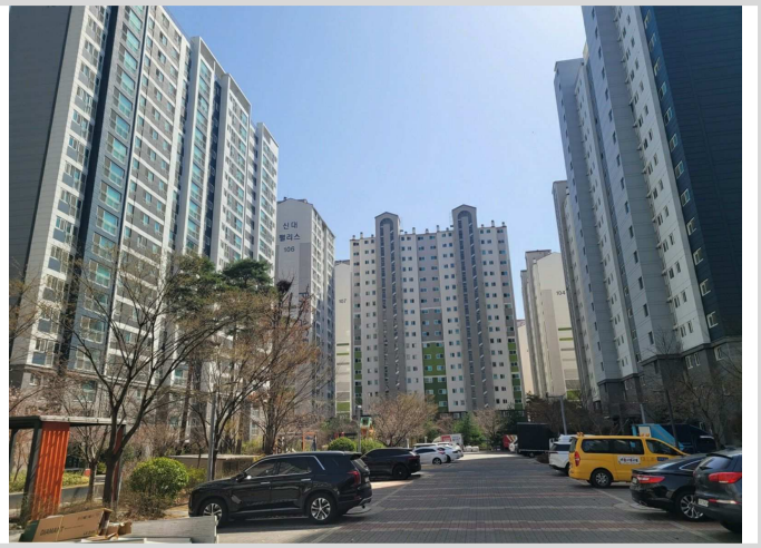
아파트단지 내부 전경 (전경 북서측에서 촬영)
