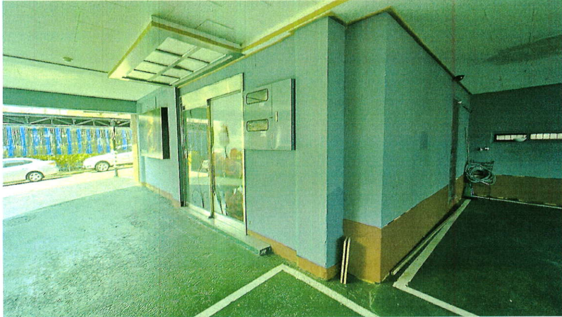
본건 건물 1층 사진
