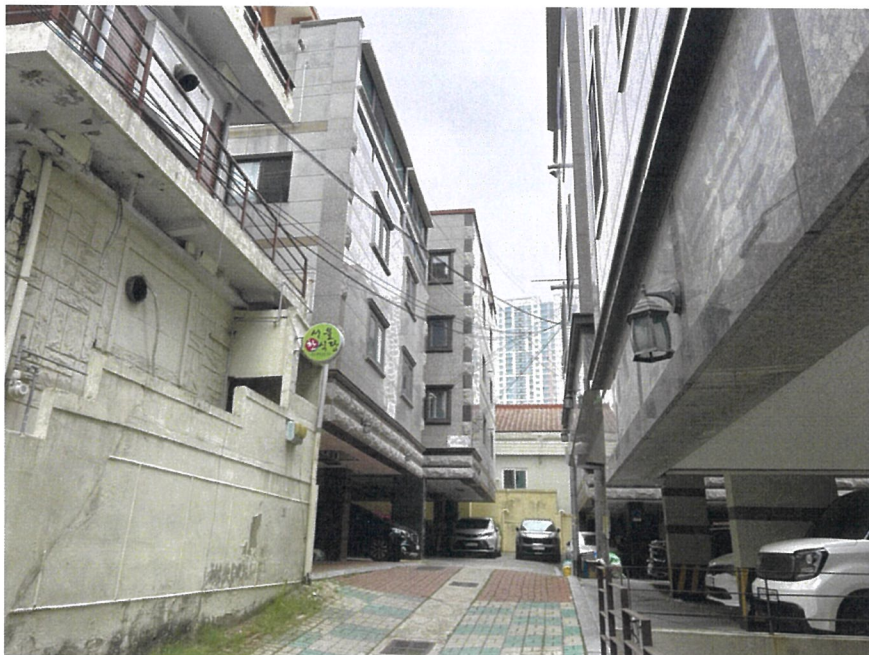
본건 일련번호(2) 전경 : 남측에서 촬영
