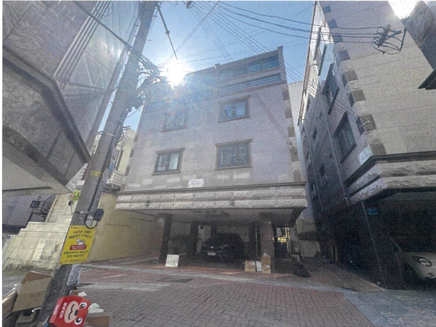
본건 일련번호(3) 전경 : 동측에서 촬영
