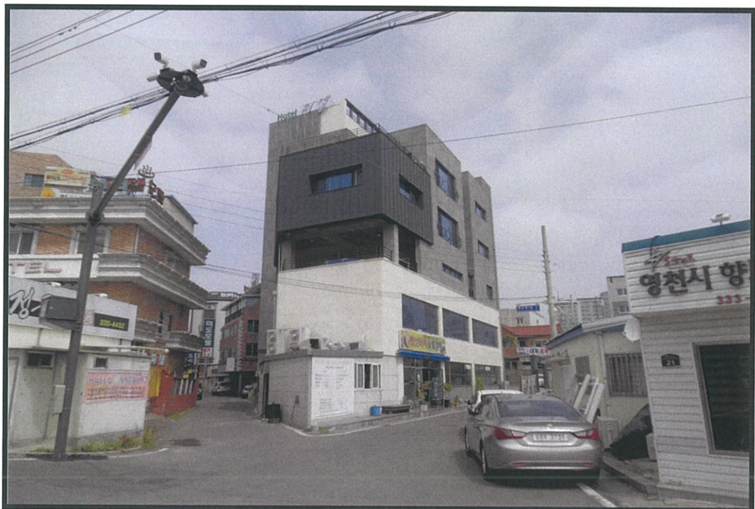
【남측에서의 본건 전경】
