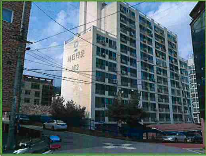
본건 단지 전경(남서측에서 촬영)
