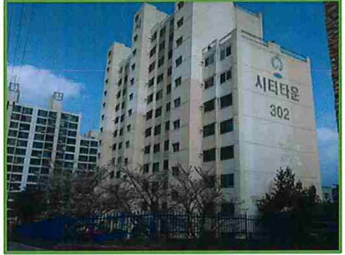
본건 단지 전경(남서측에서 촬영)
