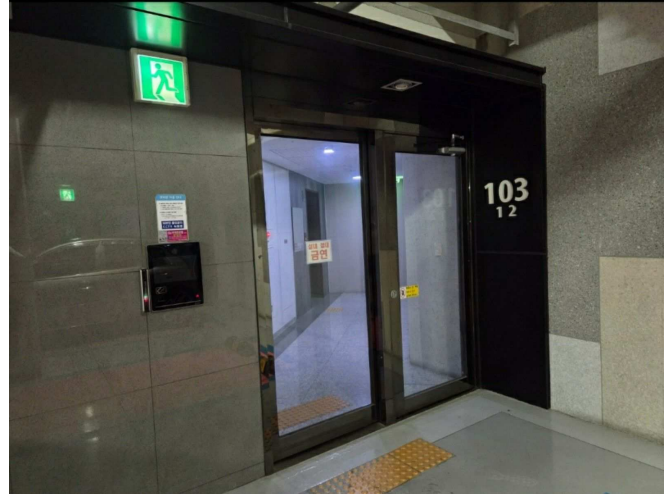
본건 동 지하1층 출입구부분
