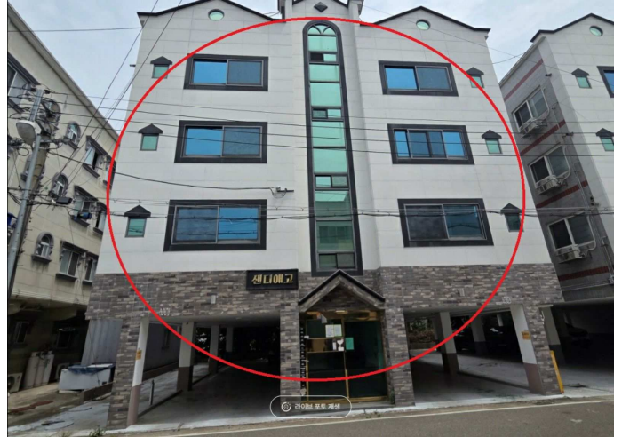
본건 전면 전경
