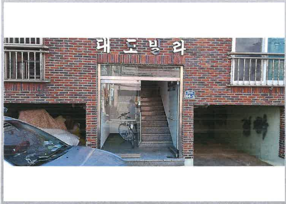
본건 1층 출입문
