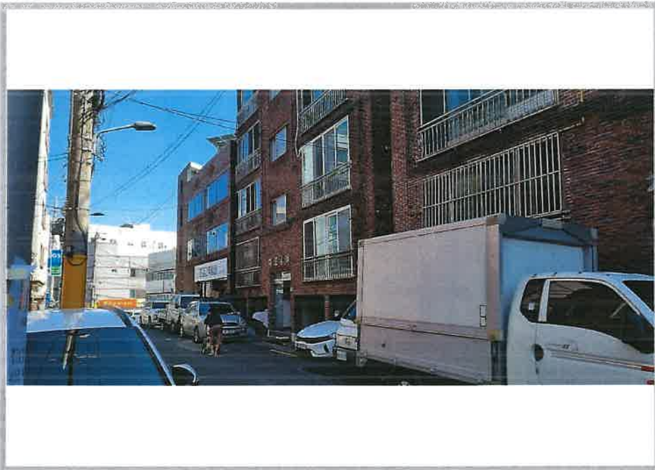
본건 다세대주택 외부 전경
