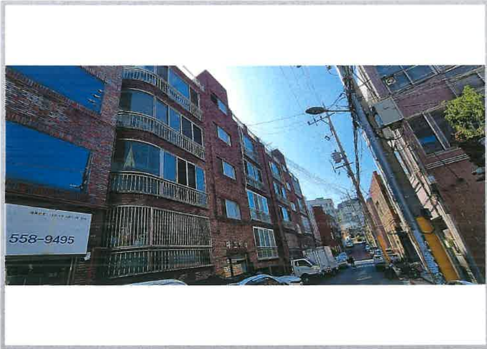
본건 다세대주택 외부 전경
