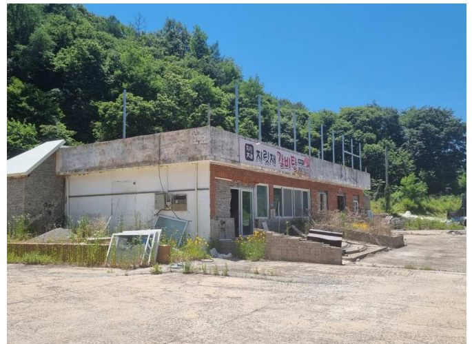
본건 전경(건물 측면)
