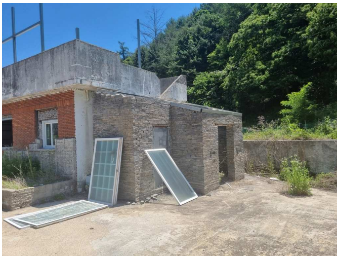
제시외 건물(벽돌조 창고-공사 중단 상태)
