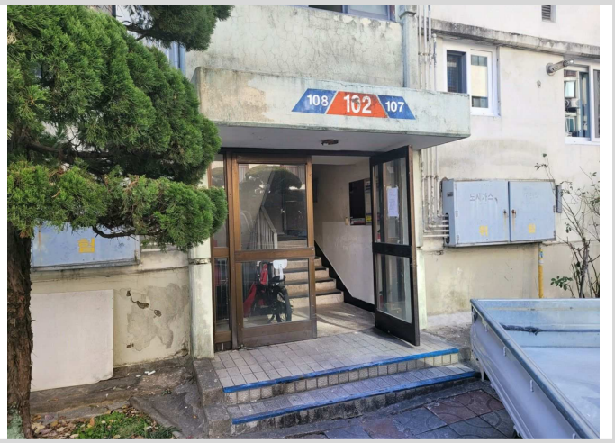
건물동 호별라인 공동출입구 전경
