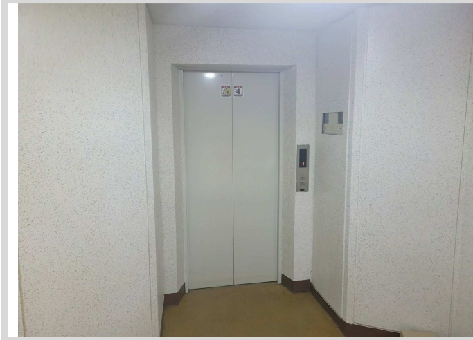
건물동 내 승강기 전경
