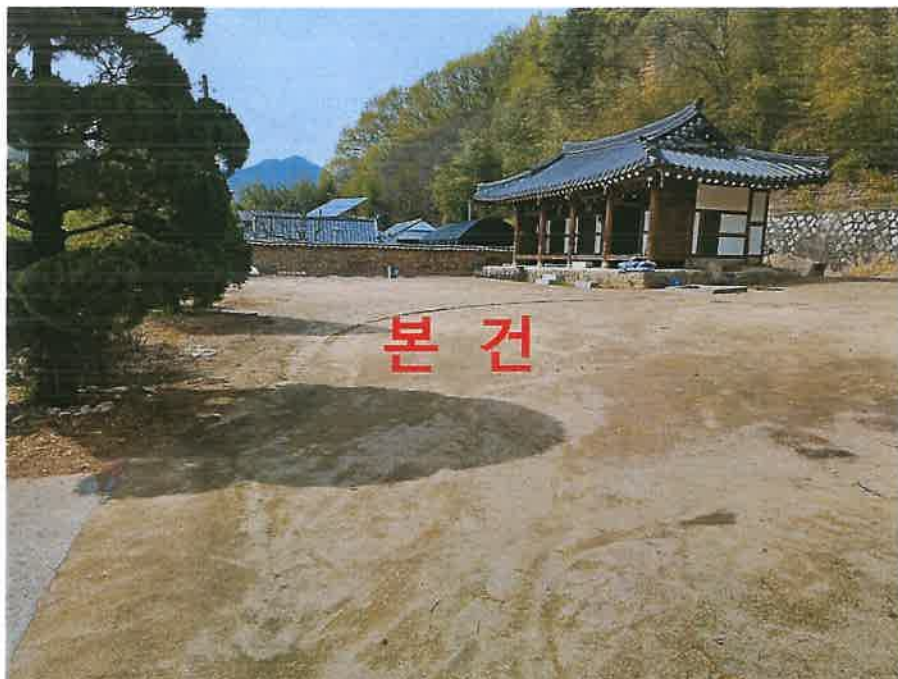
본건 남동측 전경
