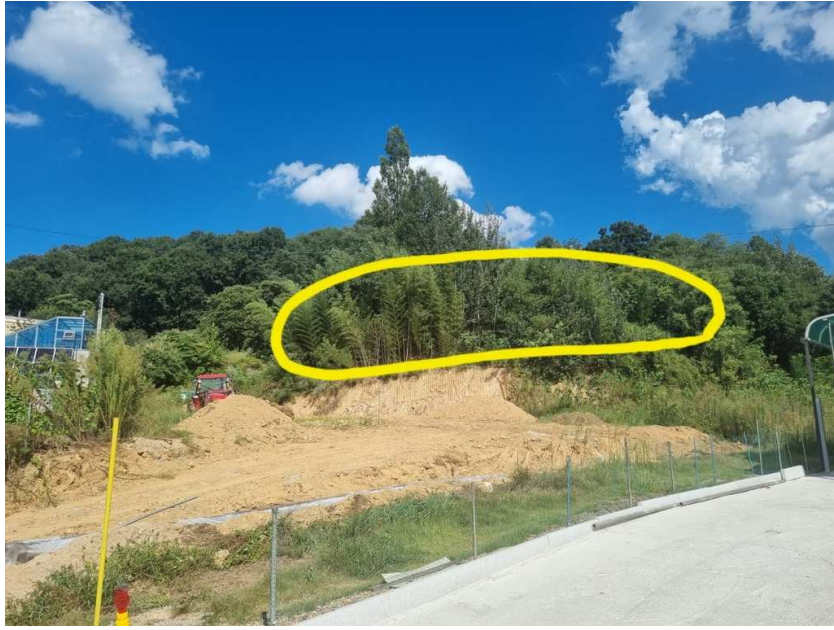
본건 전경(본건 남서측에서 촬영)
