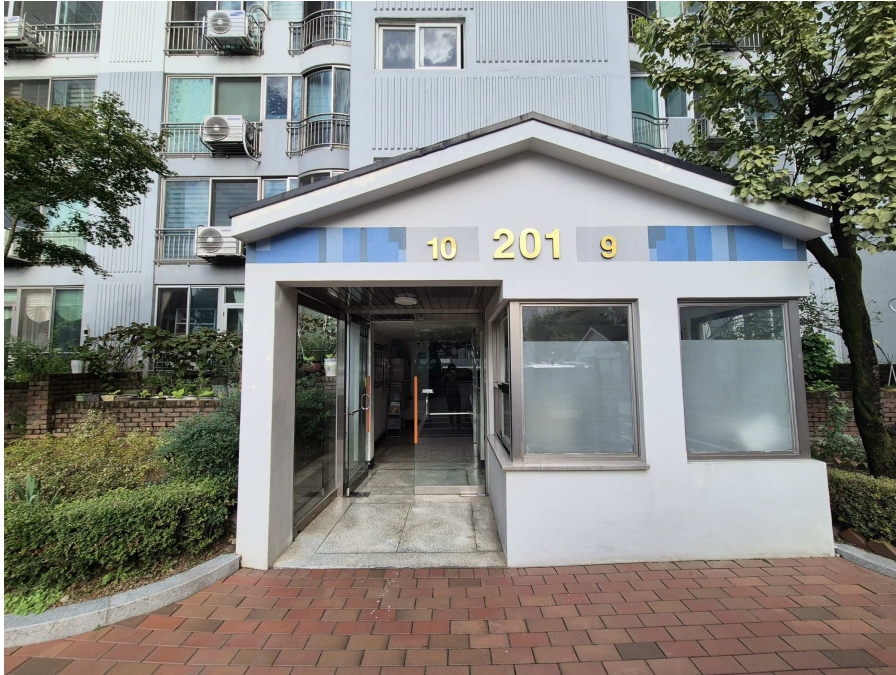
공동 현관문 전경
