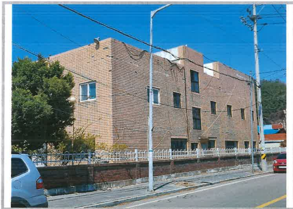
본건 기호(2)건물(1,2층 슬래브지붕 부분) 전경
