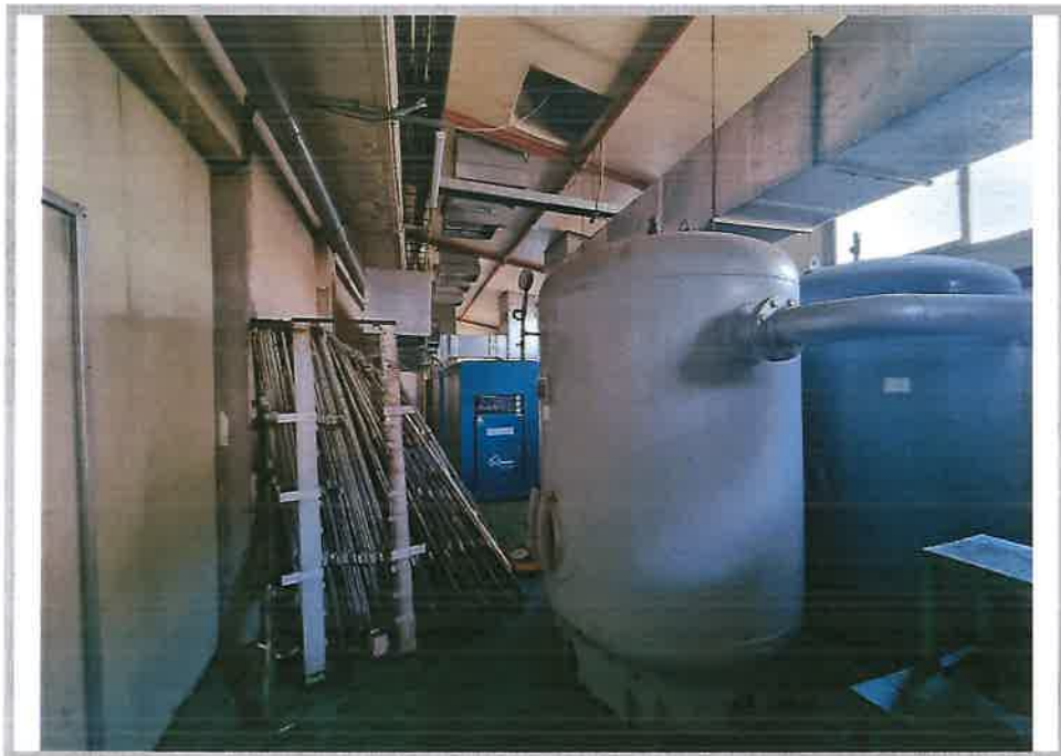
본건 기호(2-3) 건물 내부전경
