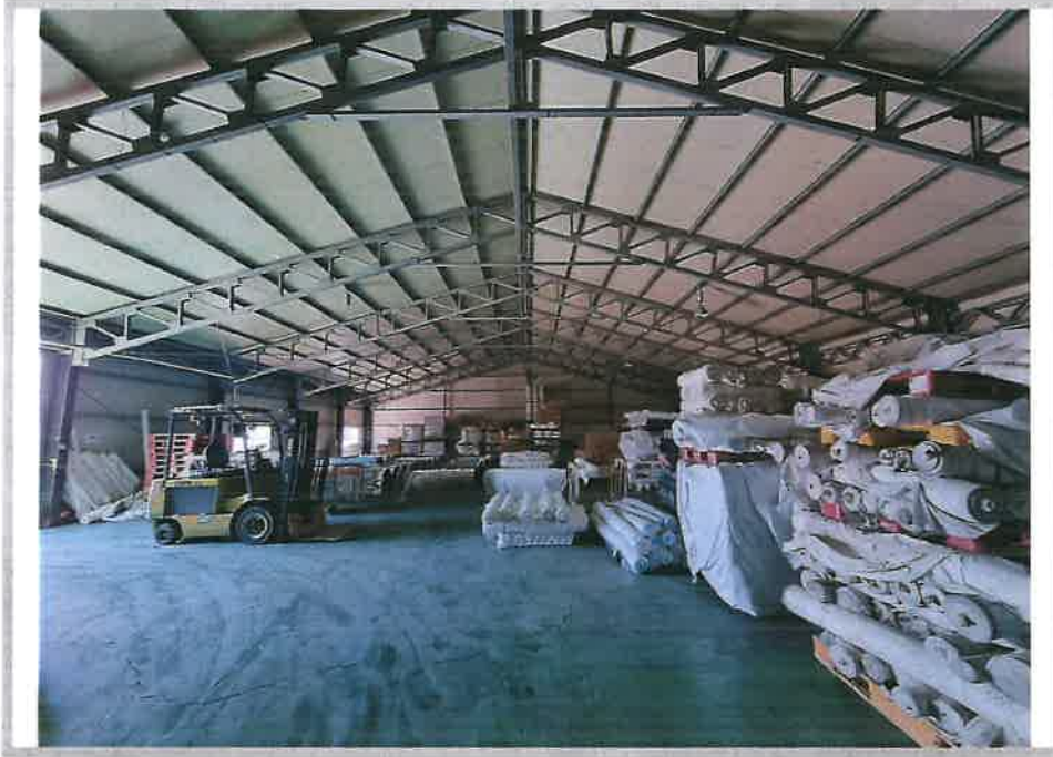
본건 기호(2)건물 1층 창고 내부전경
