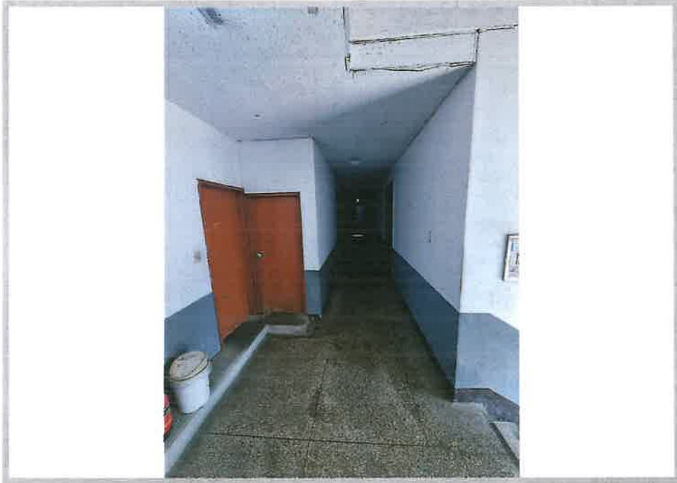
본건 기호(2)건물 2층 내부전경
