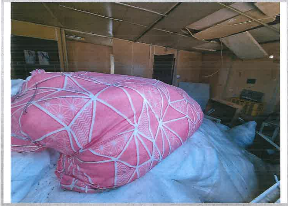
본건 기호(2-2) 건물 내부전경
