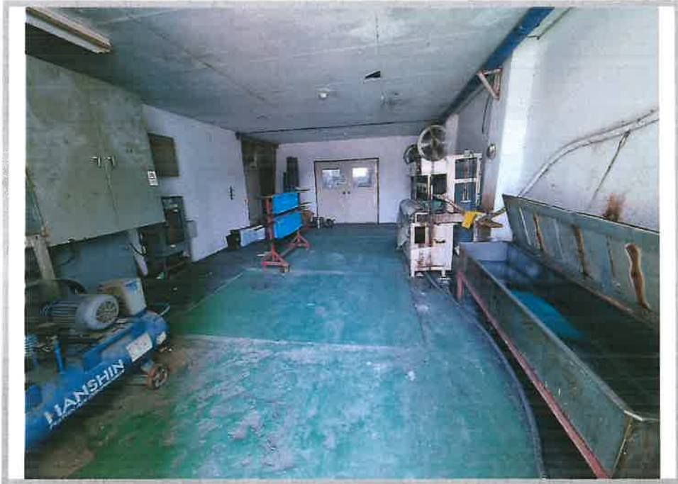
본건 기호(2)건물 1층 창고 내부전경
