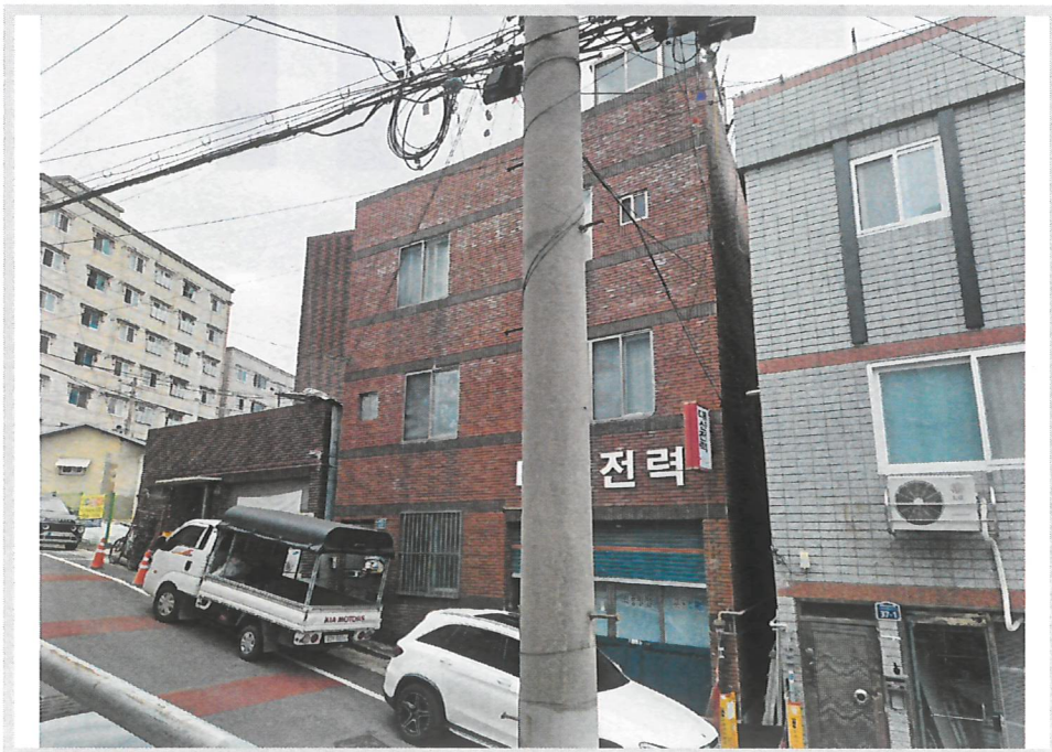
본건 전경(북동측 촬영)
