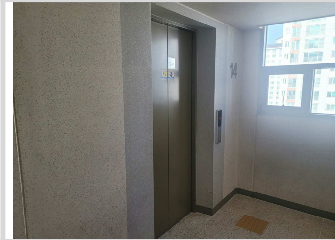
건물동 내 승강기 전경
