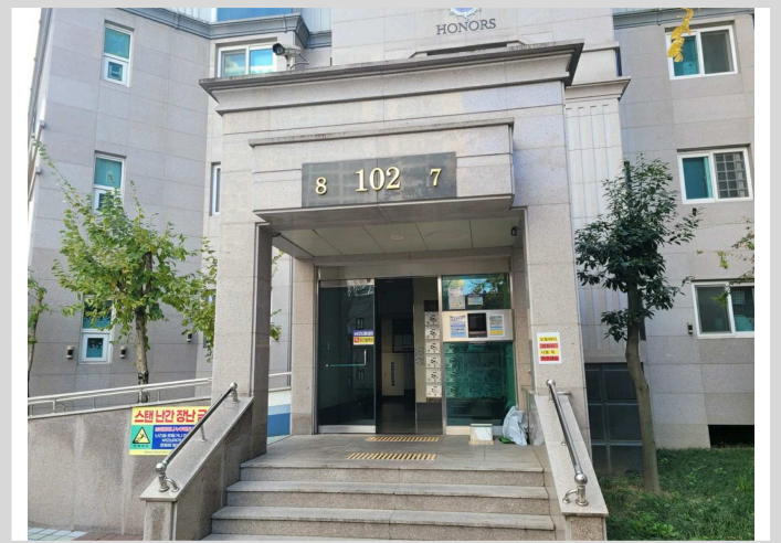
건물동 호별라인 공동출입구 전경
