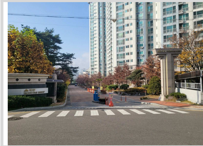
아파트단지 출입구 전경 (동측에서 촬영)
