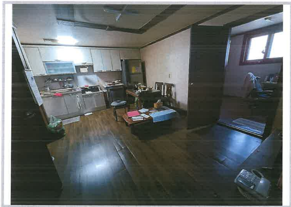
기호 2)건물 1층 내부
