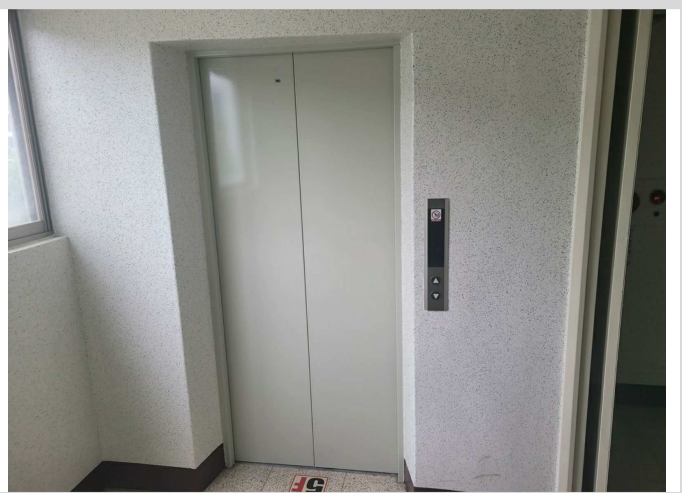
건물 내 승강기 전경
