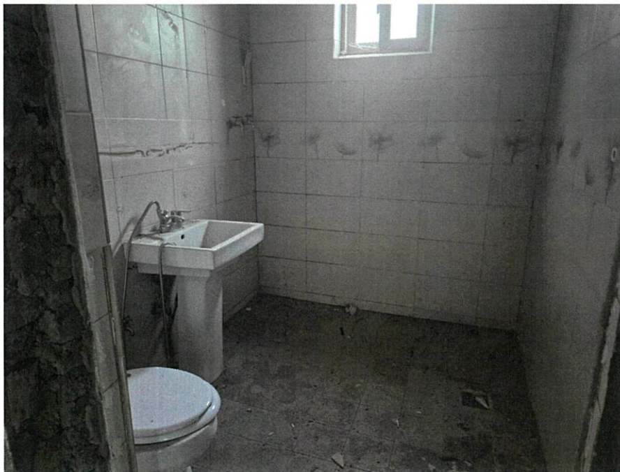
[일련번호 가) 1층 북측 1가구 철거 상태-화장실]
