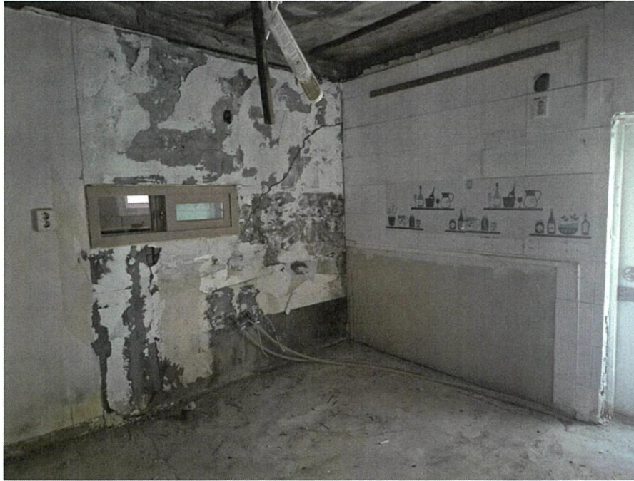
[일련번호 가) 1층 북측 1가구 철거 상태-주방]
