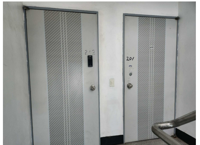
건물2-가 2층 내부 전경
