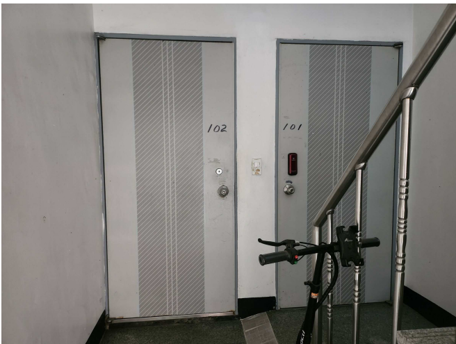
건물2-가 1층 내부 전경
