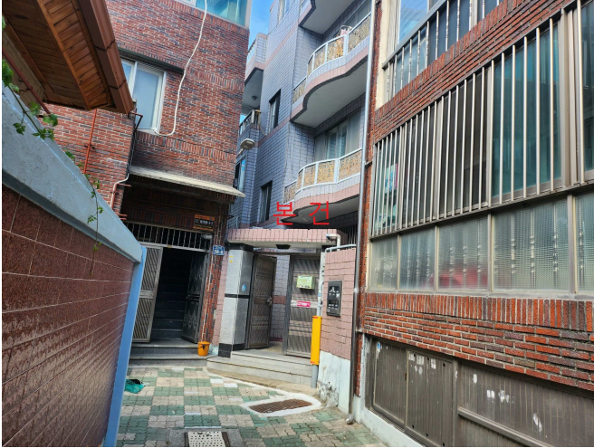
본건 전경(남서측에서 촬영)
