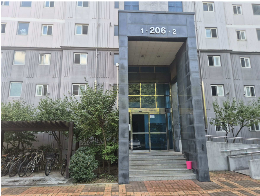
본건 공동현관문 전경
