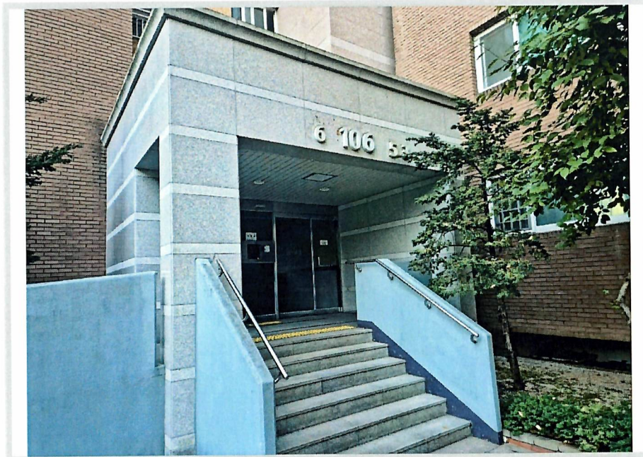
본건 1층 공동출입구
