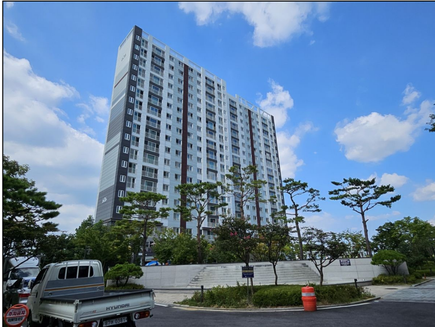
[대상물건 606동 전경]
