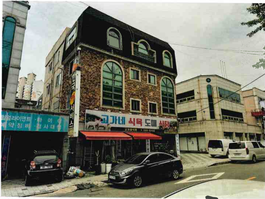
본건 전경(남동측에서 촬영)
