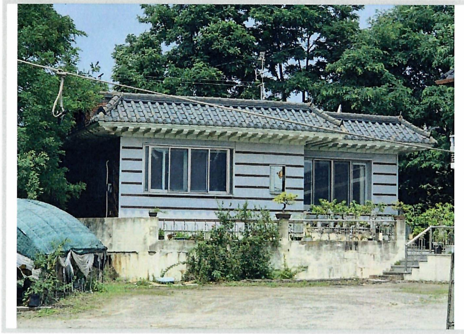
기호(3) 건물 전경
