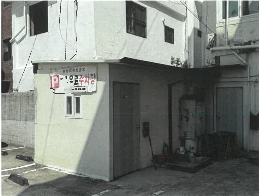
제시외 건물 (ㄱ) 전경
