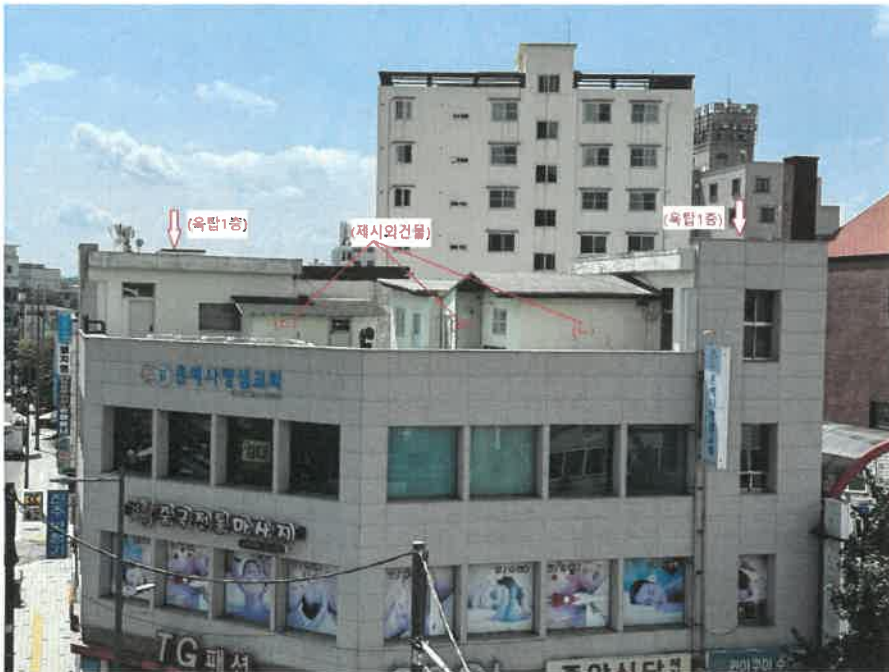
본건 옥탑1층 및 제시외 건물(L, C, R) 전경
