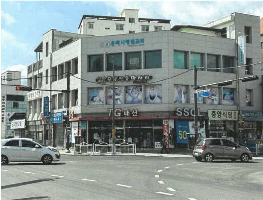
본건 기호 (1, 2) 토지 건물 전경
